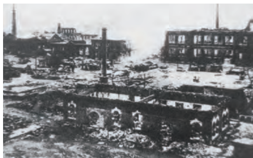
関東大震災被災状況 「隅田川べりの蔵前にあった東京高等工業の惨状」
