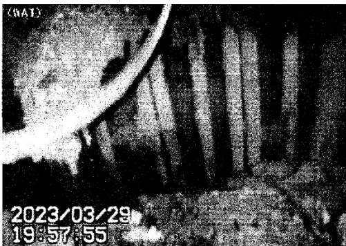
ベテスタルの鉄筋（左）と2号機 影、国際原子力研究開発機構提供
